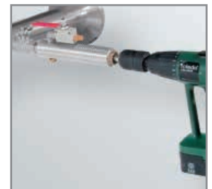
Anbohren unter Druck mit der CS Bohrvorrichtung
