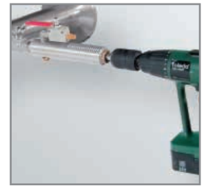
Anbohren unter Druck mit der CS Bohrvorrichtung
